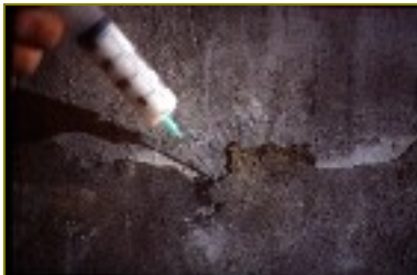
Fot.22 Durante o tratamento de escamação do intonaco.
