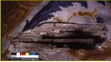
Fot.19 Apodrecimento da madeira do fasquiado
