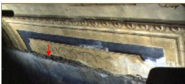
Fot.17 e 18 Lado esquerdo da abóbada (do ponto de vista do observador), com problémas graves de destacamento e perda de argamassas, fasquiado, camada pictórica.
