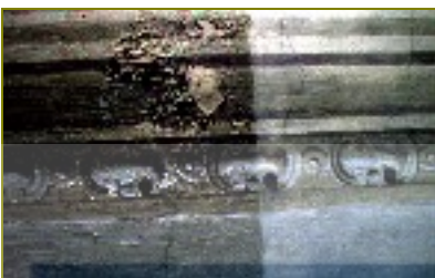
Fot.20 Durante a fixação e limpeza da camada pictórica
