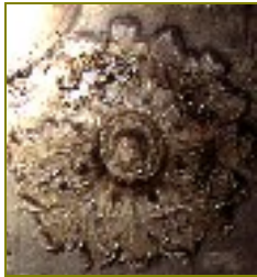
Fot. 8 Pulverulência de toda a pintura
