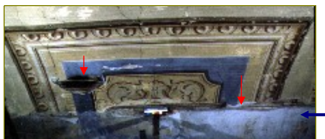
Fot.17 e 18 Lado esquerdo da abóbada (do ponto de vista do observador), com problémas graves de destacamento e perda de argamassas, fasquiado, camada pictórica.
