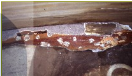
Fot. 3 Vestígio da abóbada de origem
